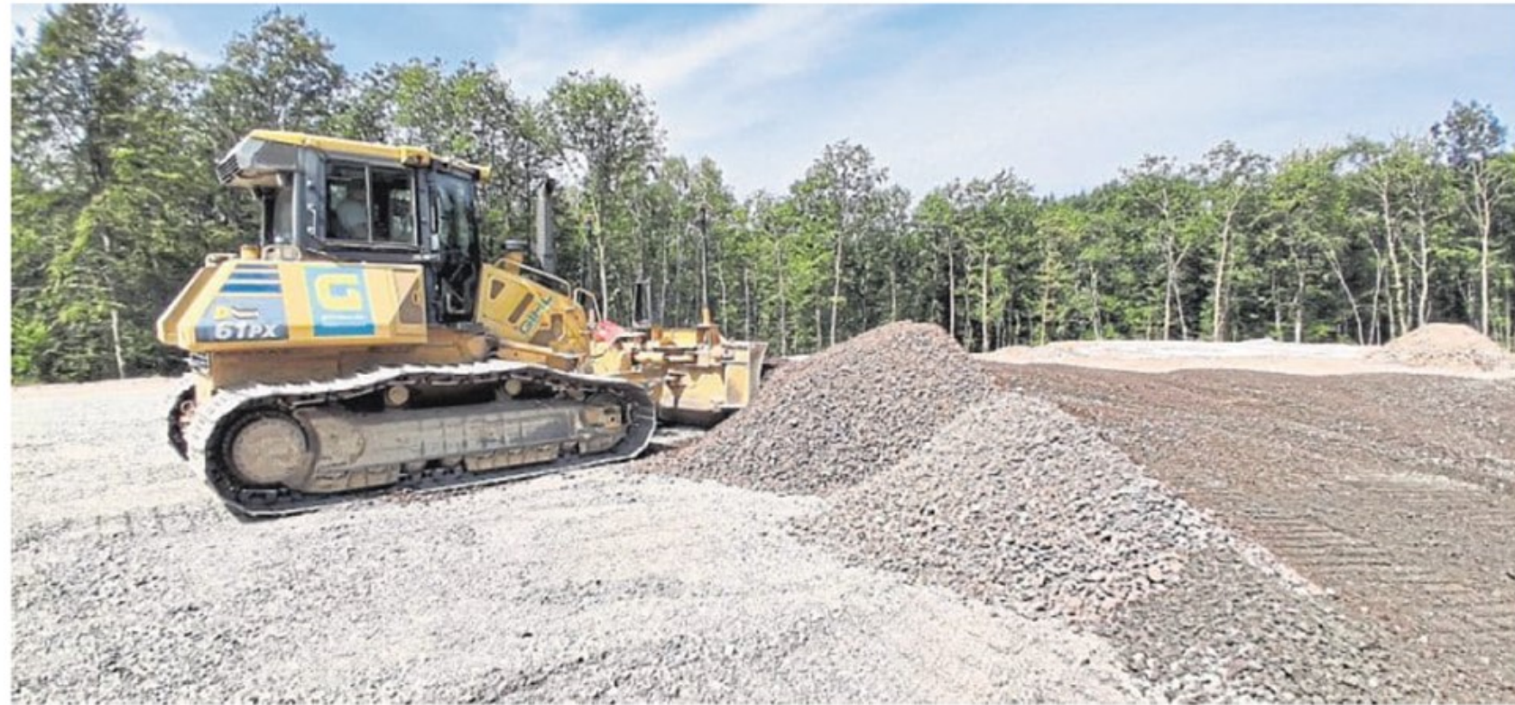
Der Bereich Siesbach Süd, wo die Windräder entstehen sollen, wird aktuell mit Schotter ausgefüllt.
