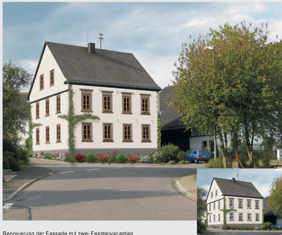
Renovierung der Fassade mit zwei Fenstervarianten
